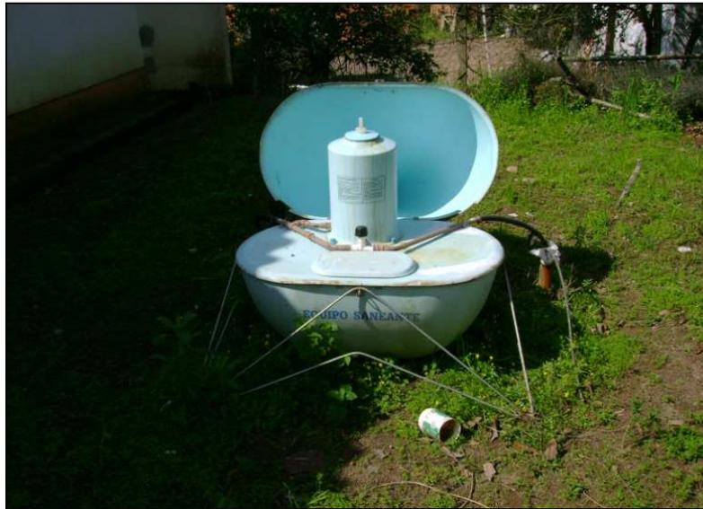
**Figura 10** – Sistema de dosagem por pastilha de cloro.
