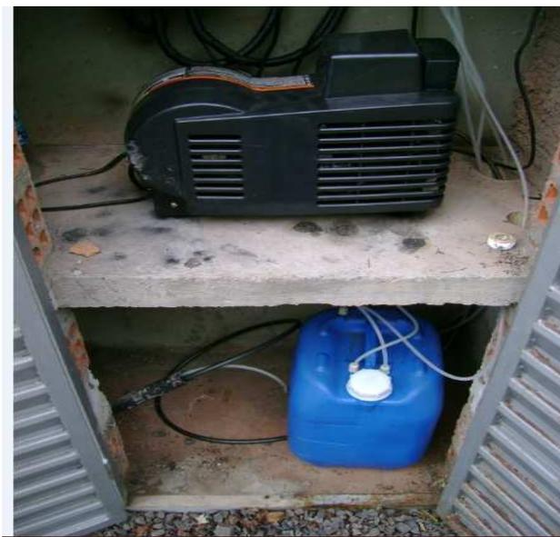
**Figura 9** – Sistema Bomba dosadora com solução líquida.
